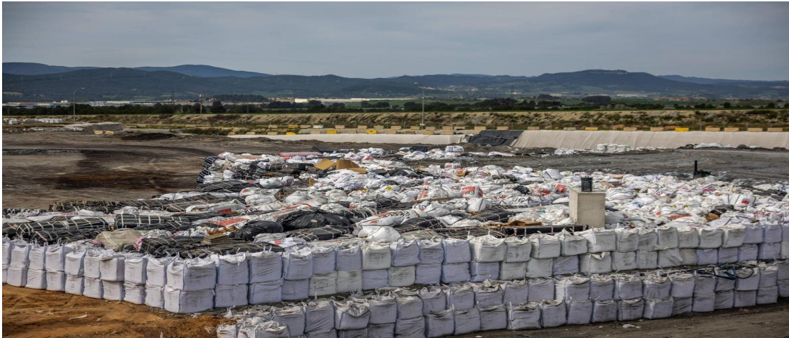
Imagen 2. Depósito en vertedero autorizado de residuos que contienen amianto bajo el modelo tradicional de confinamiento prolongado.
