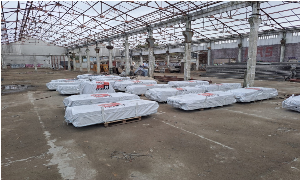
Imagen 1. Intervención técnica en cubierta con potencial liberación de fibras de amianto. La manipulación del material requiere protocolos estrictos de seguridad para minimizar el riesgo de exposición aérea.
