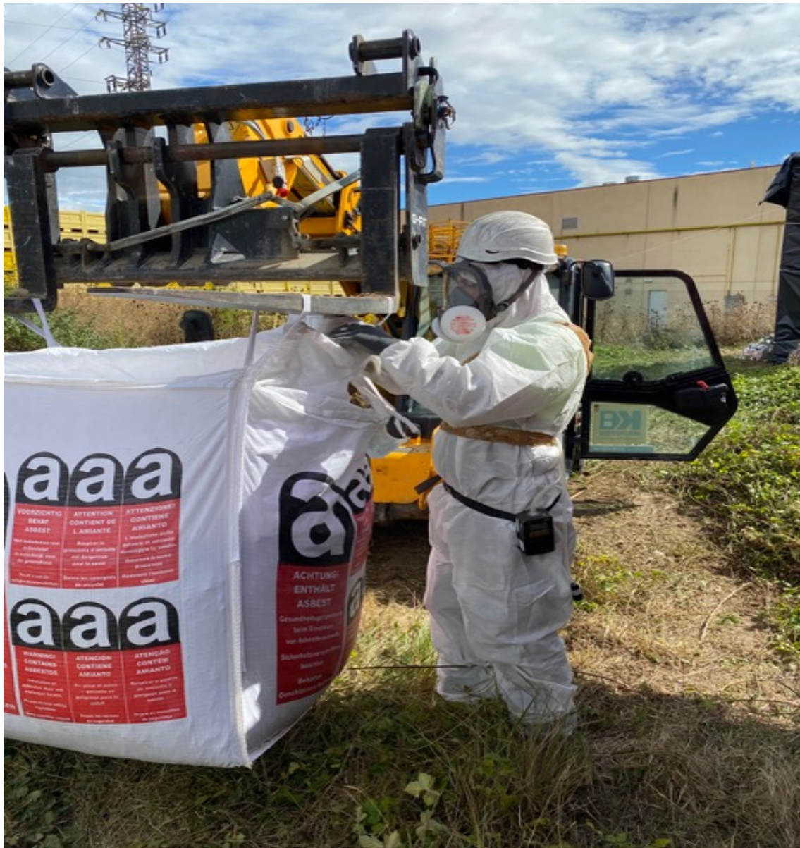
Imagen 3. Manipulación y almacenamiento temporal de residuos con amianto en sacas homologadas (big bags) bajo protocolo de seguridad.
