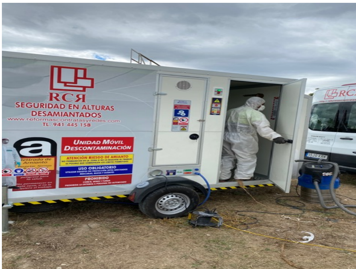
Imagen 4. Unidad móvil de descontaminación y apoyo logístico en operaciones de retirada controlada de amianto.
