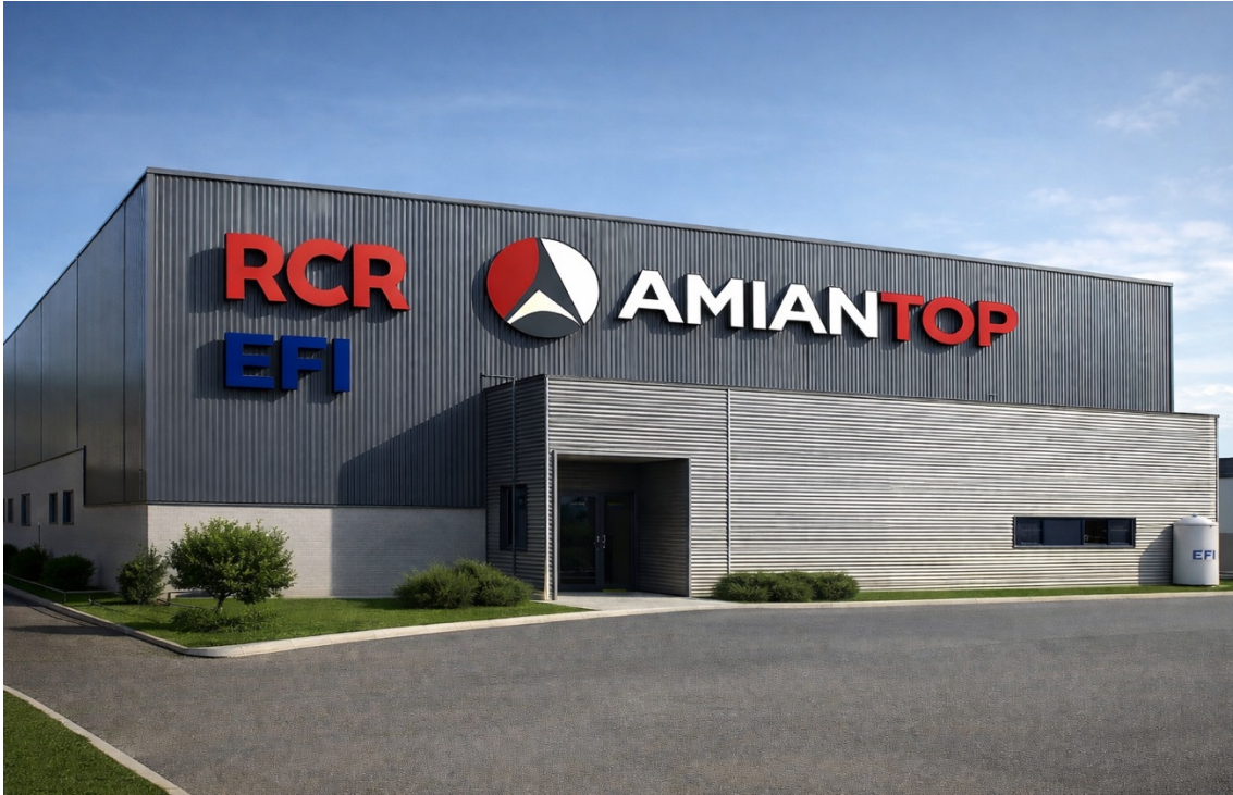
Imagen 5. Infraestructura industrial AMIANTOP – Configuración base con tecnología FS GREEN® (9,8 t/día).
